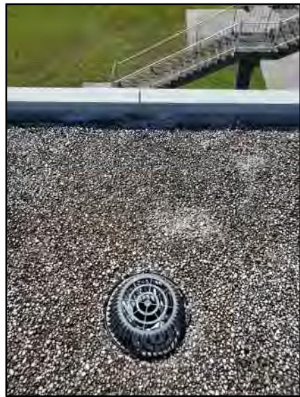
PHOTO # 10 ROOF AREA E1
