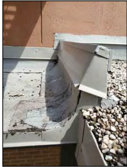
PHOTO # 13 ROOF AREA E3
