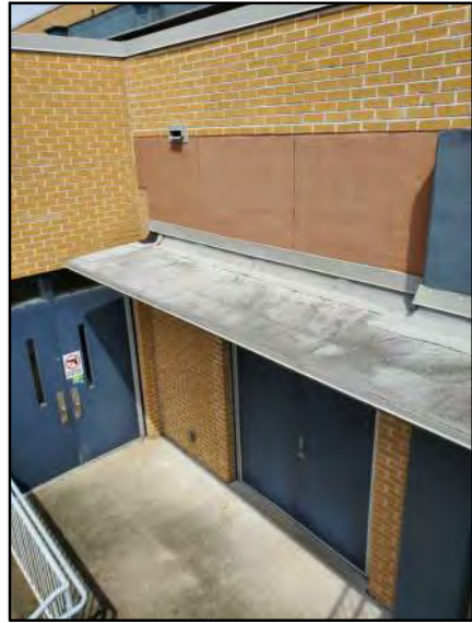
PHOTO # 14 ROOF AREA E3
