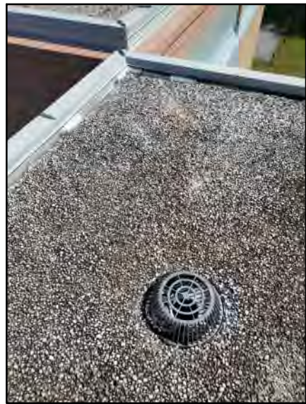
PHOTO # 9 ROOF AREA E1
