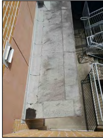
PHOTO # 15 ROOF AREA E3
