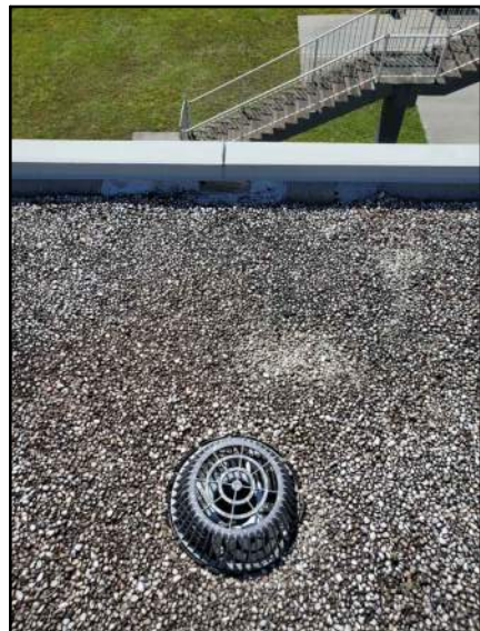
PHOTO # 10 ROOF AREA E1
