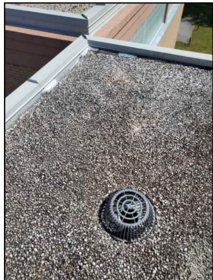
PHOTO # 9 ROOF AREA E1
