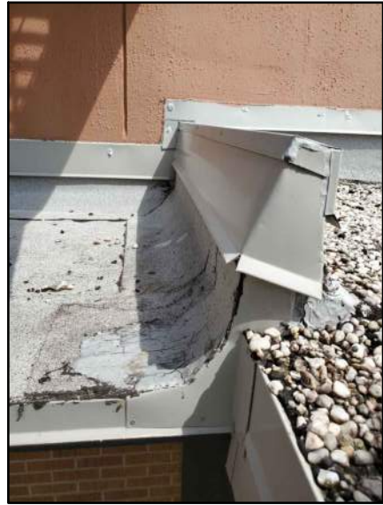
PHOTO # 13 ROOF AREA E3
