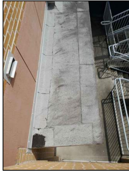
PHOTO # 15 ROOF AREA E3
